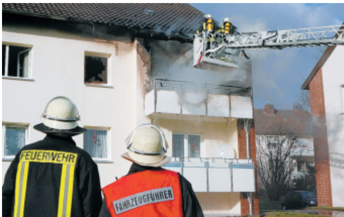
Einsatz am Grünen Weg: Vergangenen Donnerstag kam eine 77-jährige Frau ums Leben. Brandursache war eine defekte Steckdose.
